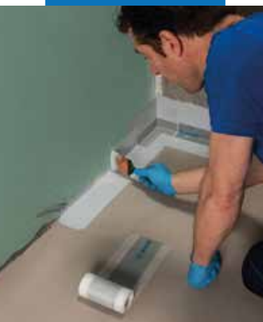
Нанесение Мареband PE 120, используя Марегум WPS
