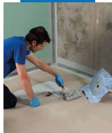
Установка Drain Vertical , используя Mapegum WPS
