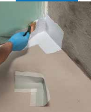
Нанесение на угол 90° углового Мареband PE 120, используя Марегум WPS
